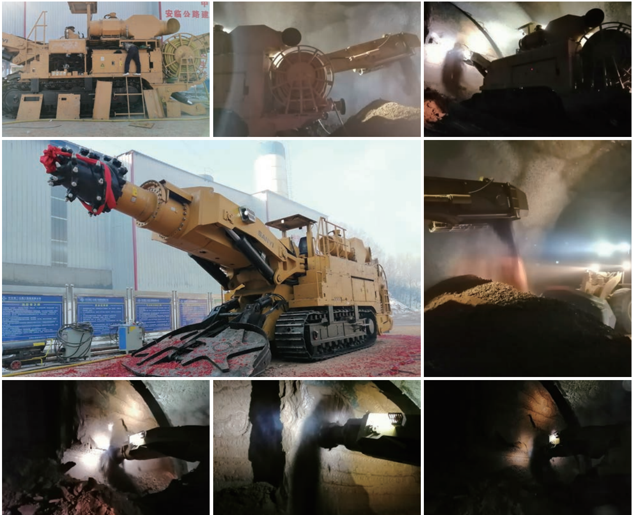
安临高速施工项目
